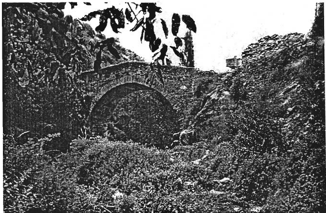
Fig. 4 Puente del Camino de la Sierra de Sedella
